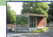
Poste de Garde
